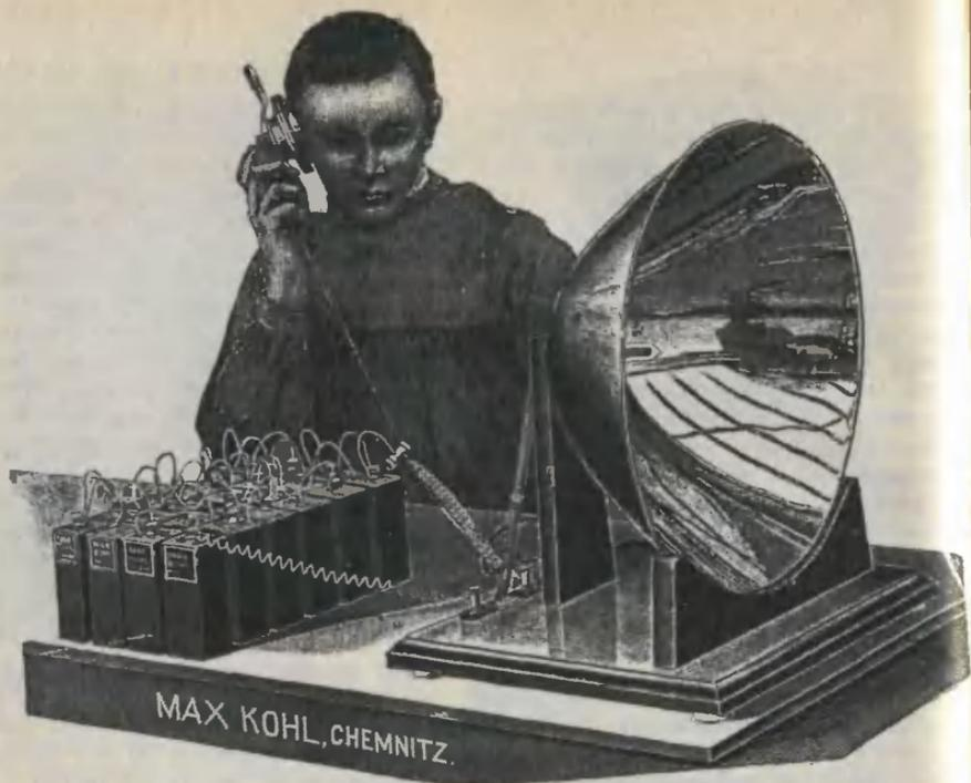
*Учебно-демонстрационный комплект оптической линии связи, выпускавшийся в Германии в начале века. Передатчик: цилиндрический предмет в левой части рисунка — генератор ацетилена для работы газовой лампы; собственно передатчик справа; в центре — каучуковая трубка с раструбом для усиления голоса говорящего.*
